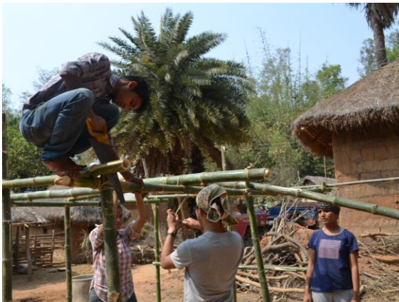
村内での建設作業
